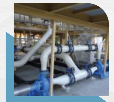
Montage de la tuyauterie sur site
